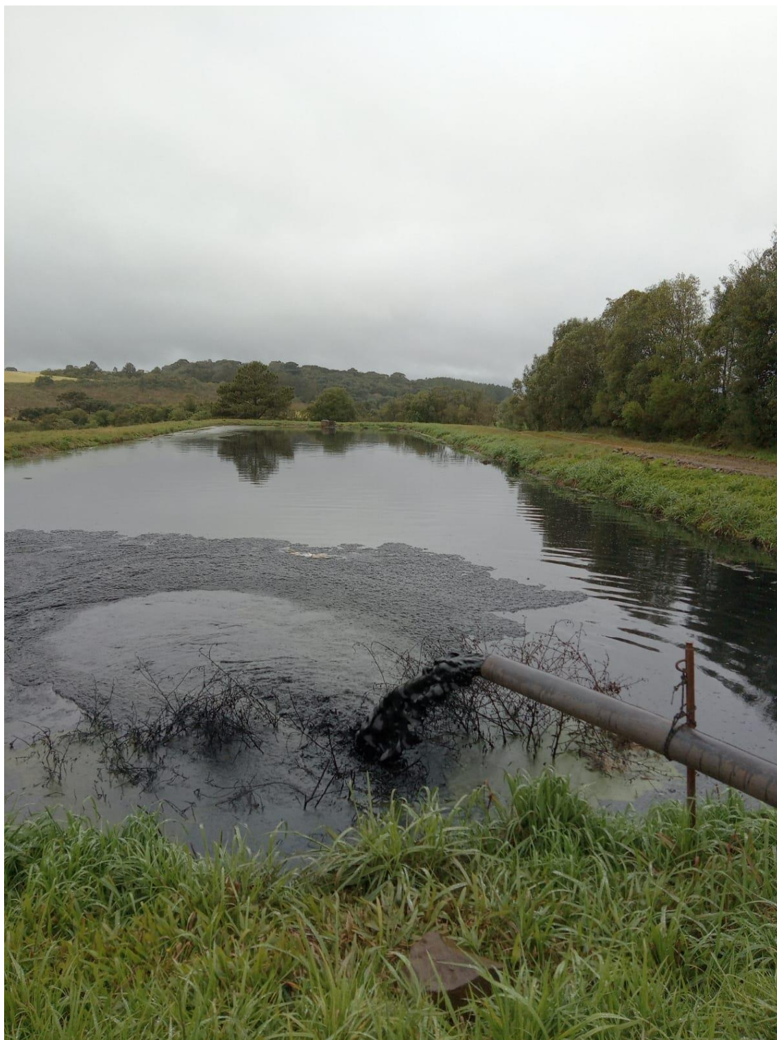
Fotografia 3 – Operação de descarga de lodo na terceira lagoa (anaeróbia 2)
