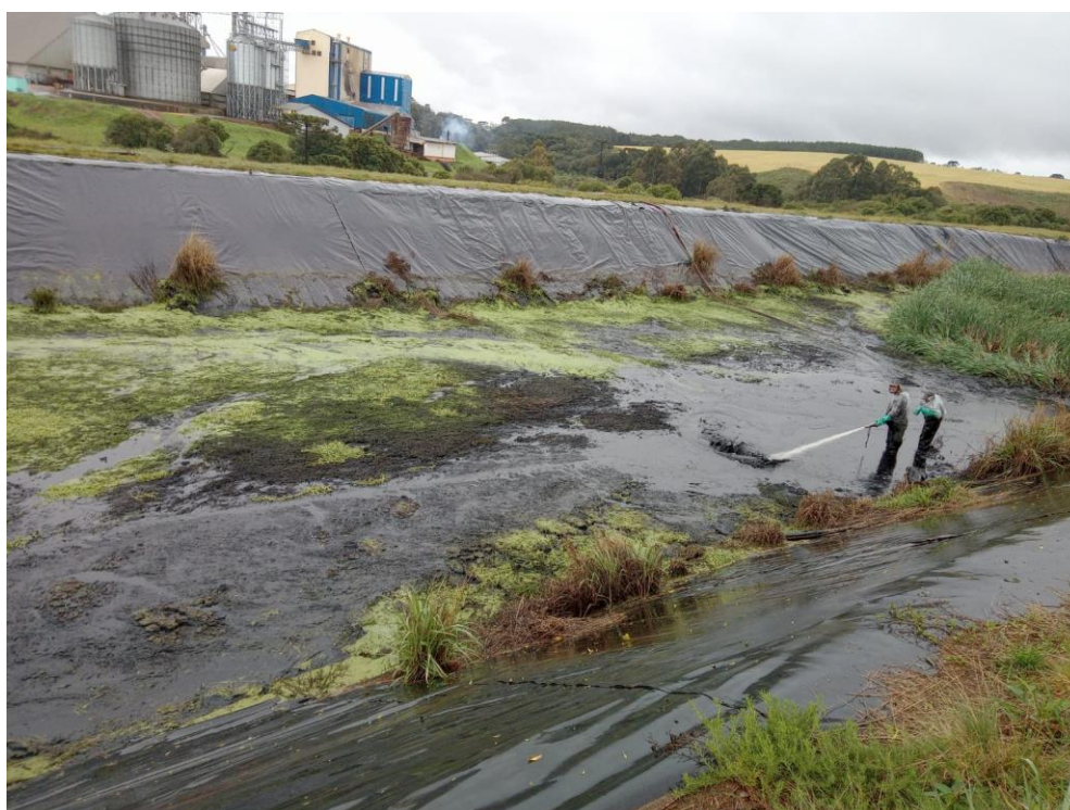
Fotografia 2 – Operação de remoção de lodo da lagoa anaeróbia 1 em evolução
