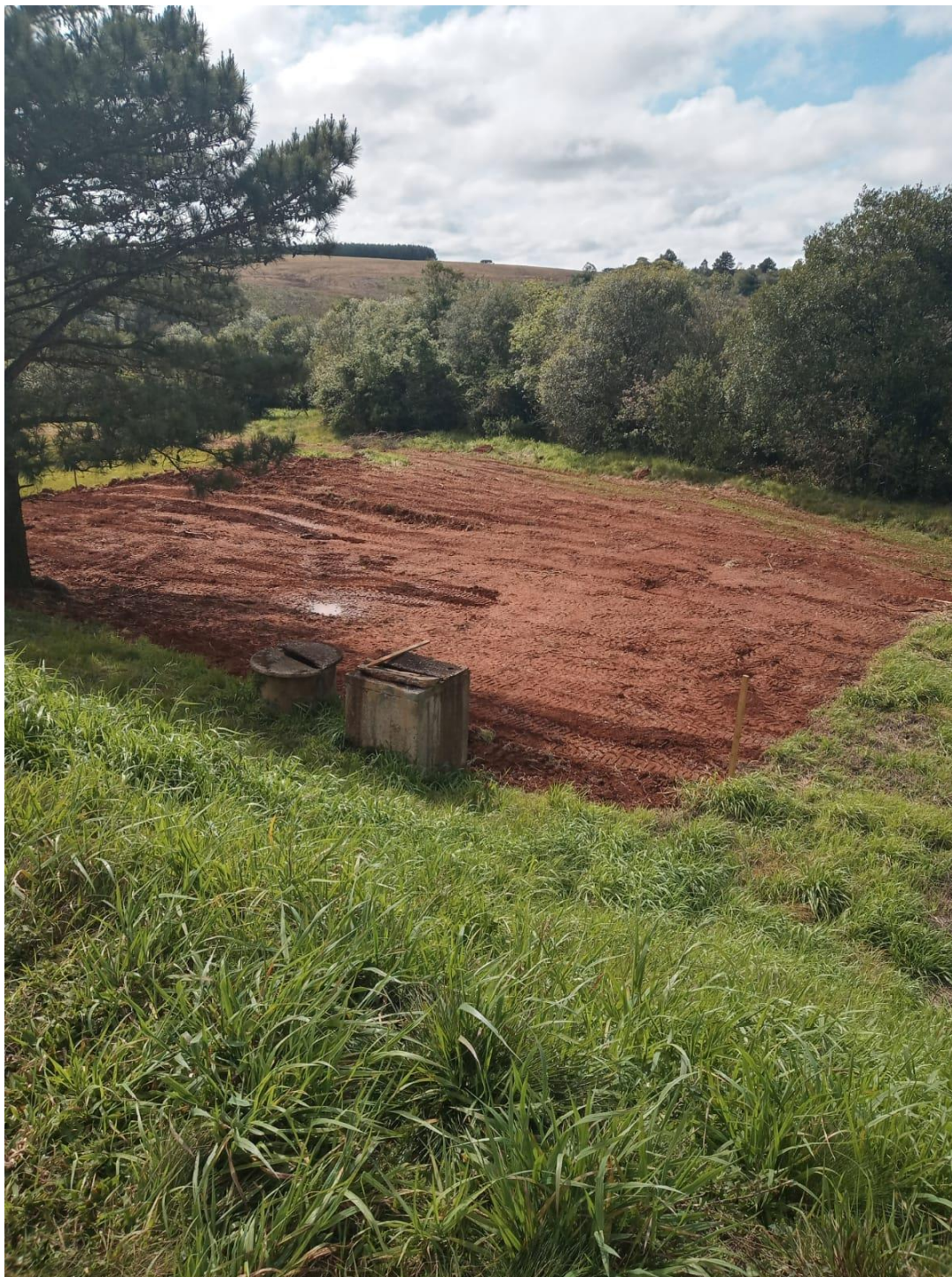
Fotografia 6 – Área destinada aos Bays de desidratação em fase de preparação.
