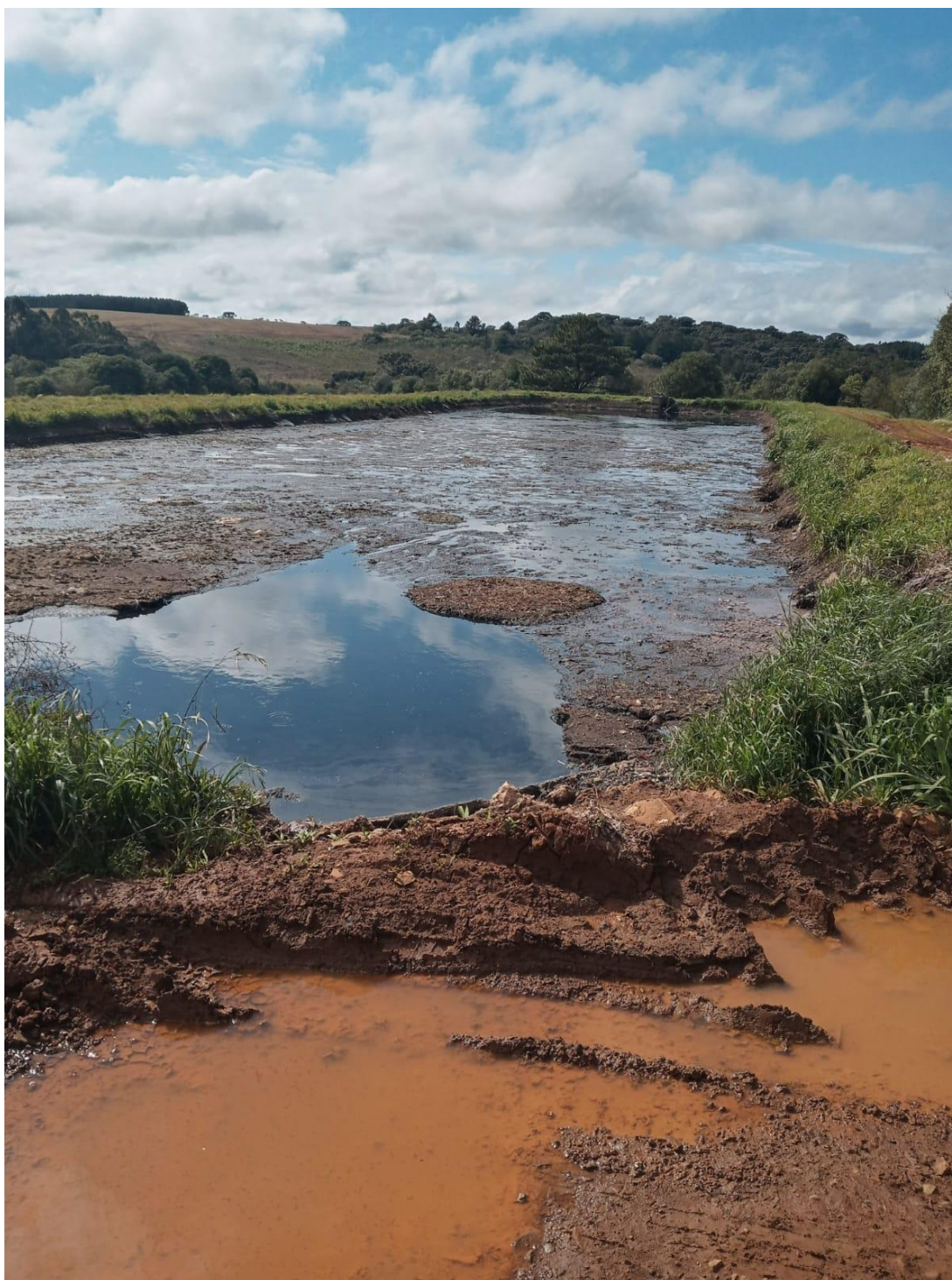
Fotografia 5 – Situação atual da terceira lagoa (anaeróbia 2) destinada a receber todo o lodo.
