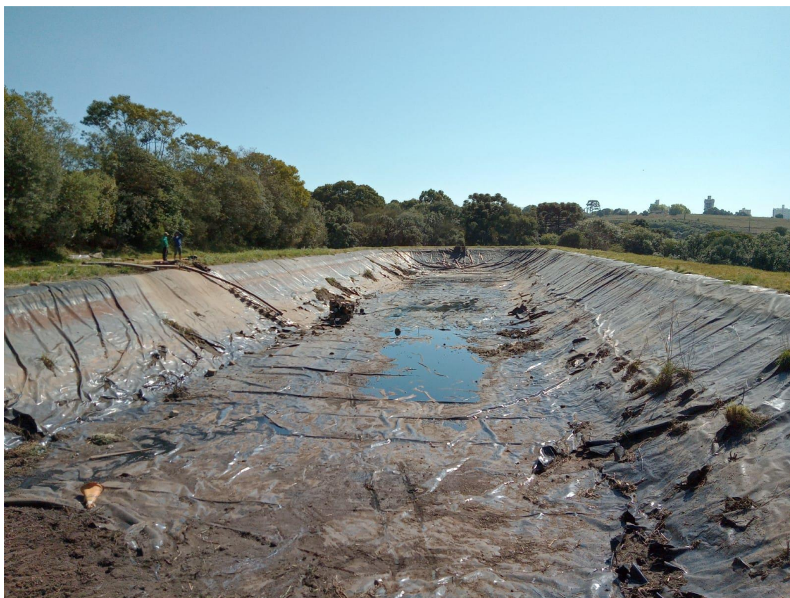
Fotografia 4 – Operação de remoção de lodo da lagoa anaeróbia 1 finalizada para receber a instalação da geomembrana
