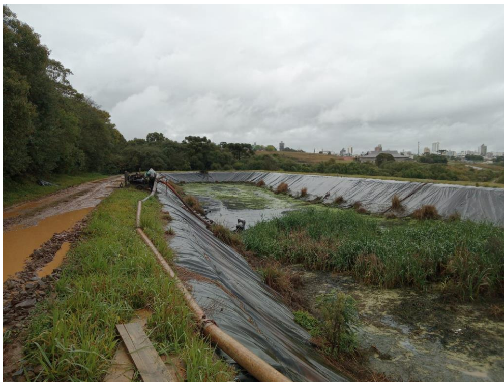
Fotografia 1 – Início da operação de remoção de lodo da lagoa anaeróbia 1
