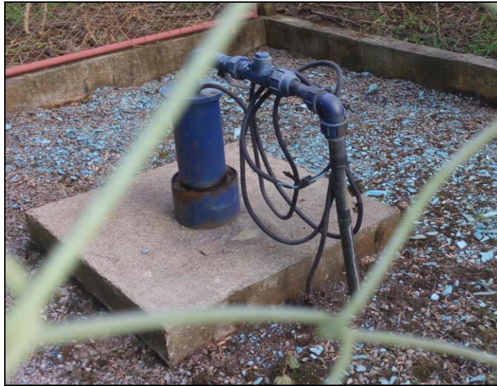
Foto 01 – Modelo de Selo Sanitário do Poço
